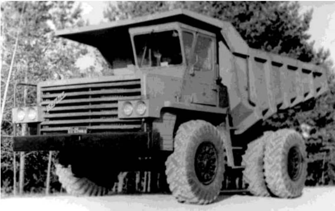
Первый опытный образец карьерного самосвала БелАЗ-540, изготовленный в ноябре 1961 г.
