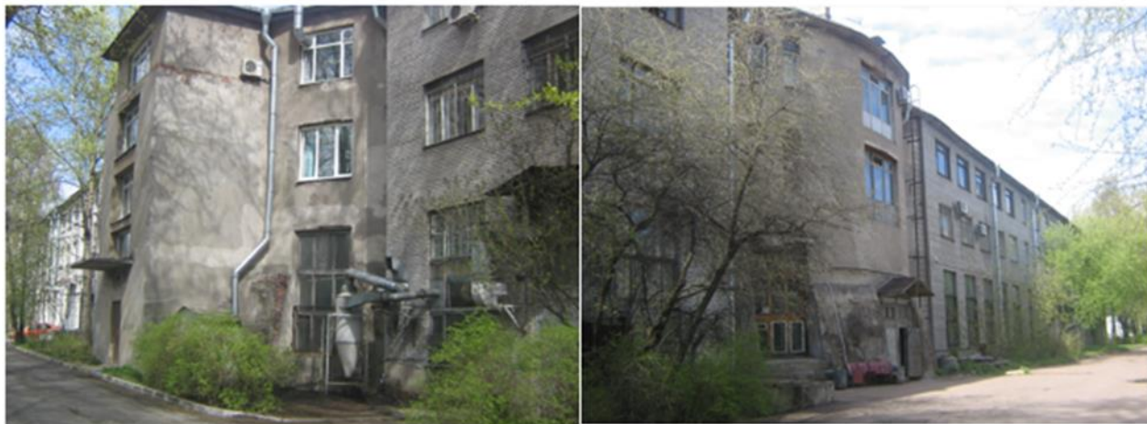
Рис. 2. Вид на офисное здание, расположенное на месте корпусов и газгольдера исторического газового завода (фото авторов).
