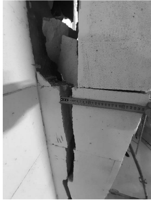
Рис. 1. Вид на обследуемую воздухозаборную камеру: а – вид на крен ограждения воздухозаборной камеры; б – силовая вертикальная трещина в ограждении камеры
