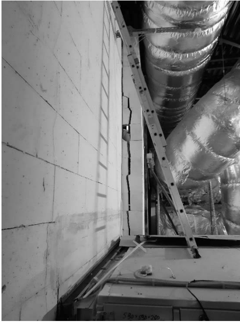
Рис. 1. Вид на обследуемую воздухозаборную камеру: а – вид на крен ограждения воздухозаборной камеры; б – силовая вертикальная трещина в ограждении камеры
