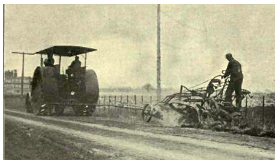
Первые автогрейдеры (устройство и работа)
