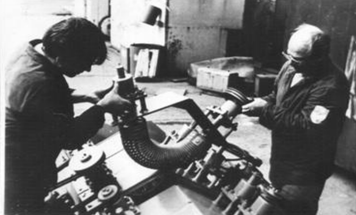
Рис. 11. Монтаж рабочего оборудования
