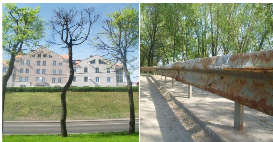
Рис. 1. Поврежденное дерево Рис. 2. Барьерное ограждение
