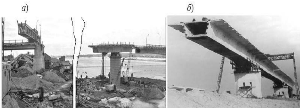
Рис. 1. Разрушение моста с проезжей частью коробчатого сечения: а – общий вид; б – фрагмент
