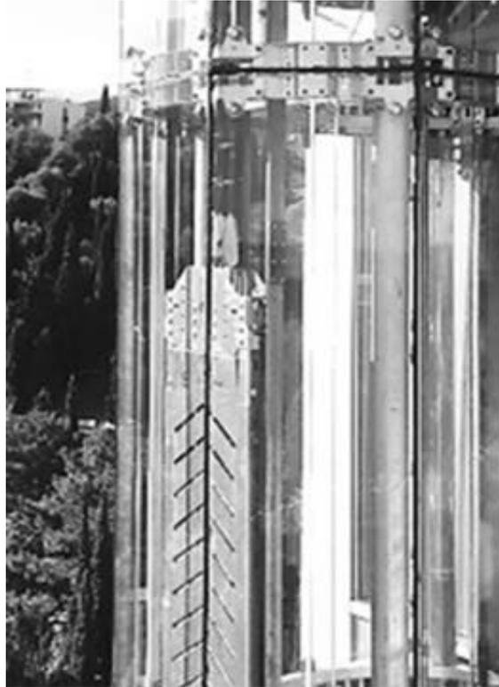
Рис. 6. Панорамный лифт большой грузоподъемности с противовесом кабины фирмы «М-Систем», грузы которого закрыты декоративными стальными щитами
