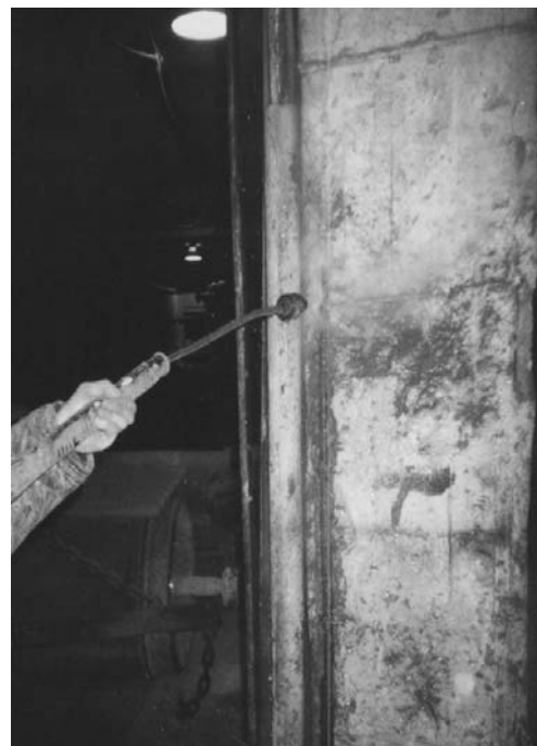
Рис. 4. Подготовка поверхности бетона и очистка арматуры гидромонитором KARCHER: а – гидромонитор KARCHER; б – подготовка поверхности бетона и очистка арматуры
