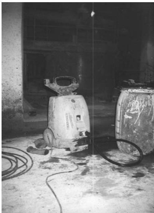
Рис. 4. Подготовка поверхности бетона и очистка арматуры гидромонитором KARCHER: а – гидромонитор KARCHER; б – подготовка поверхности бетона и очистка арматуры
