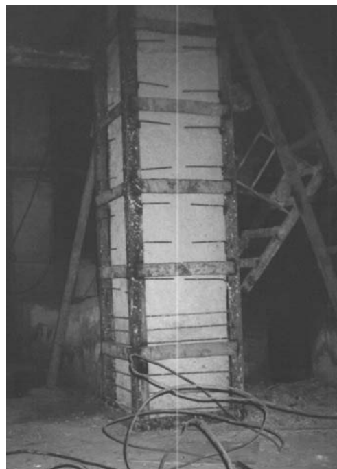
Рис. 5. Усиление железобетонной колонны стальной обоймой с обетонированием: а – верхняя часть стальной обоймы усиления; б – нижняя часть стальной обоймы усиления
