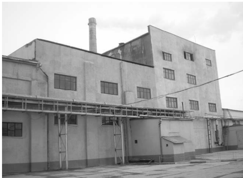
Рис. 1. Здание подготовительного отделения цеха АЦИ ОАО «Кричевцементношифер»
