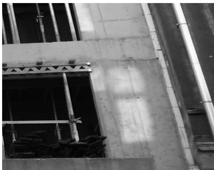
Рис. 1. Плиты беспрессового пенополистирола, уложенные между стенами зданий
