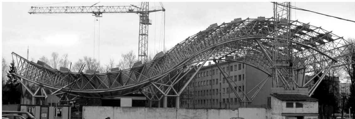
Рис. 1. Общий вид комбинированного структурного покрытия
