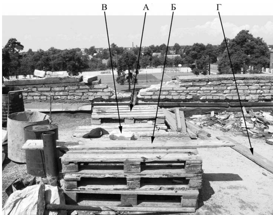
Рис. 1. Вид места установки подъемника на крыше здания
