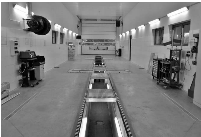
Рис. 1. Пункт технического осмотра
