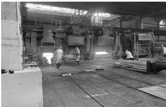
Рис. 1. Новгородский металлургический завод
