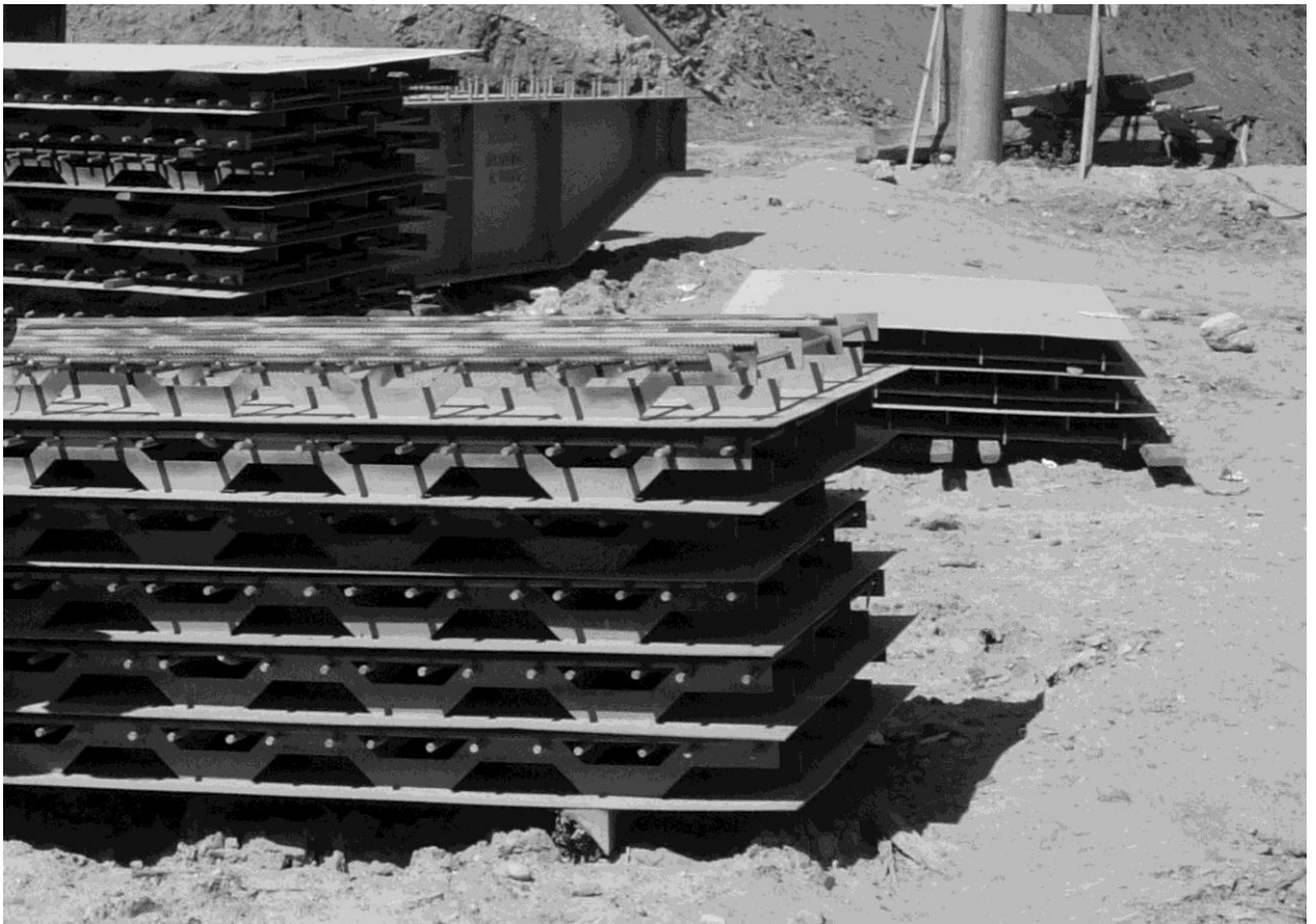
Рис.3: Стальные сварные составляющие КНЭСК на месте монтажа
