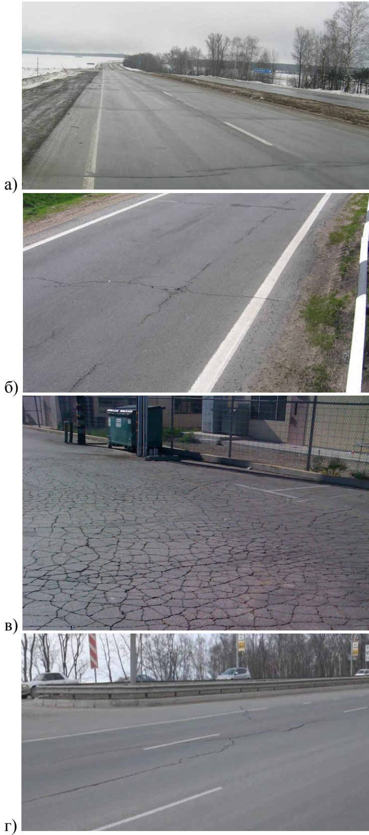
Рисунок 2 – Виды трещин в дорожных покрытиях
